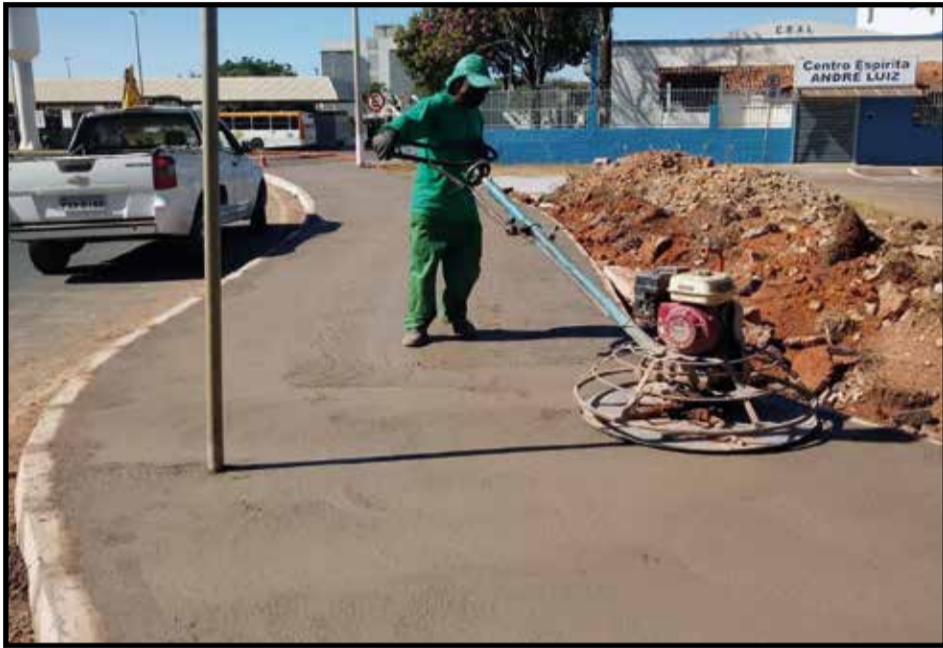
Obras incluem uma calçada de 2,5km para acesso ao Hospital Regional do Guará
