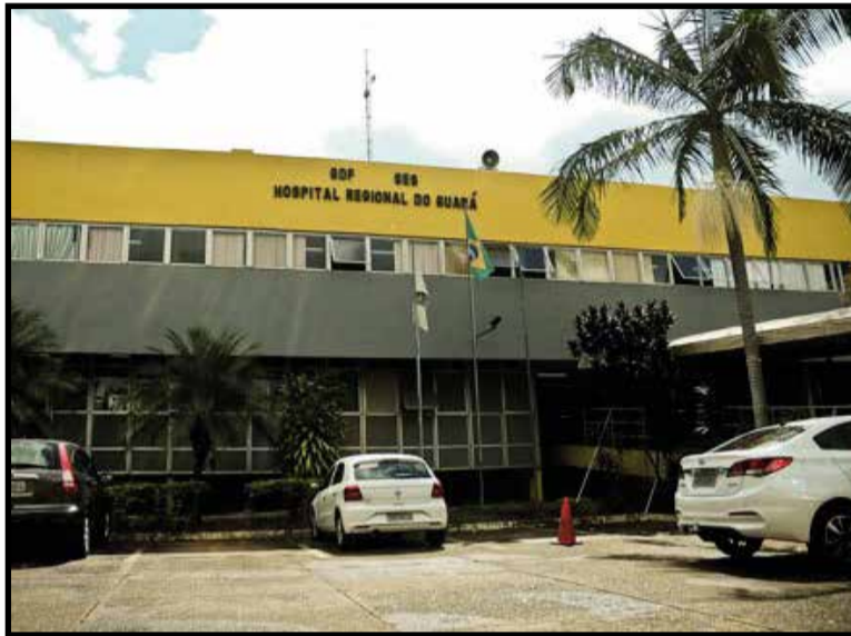
Ampliação foi possível com a reestruturação do espaço interno do prédio, sem comprometer a capacidade de atendimento de outras especialidades
