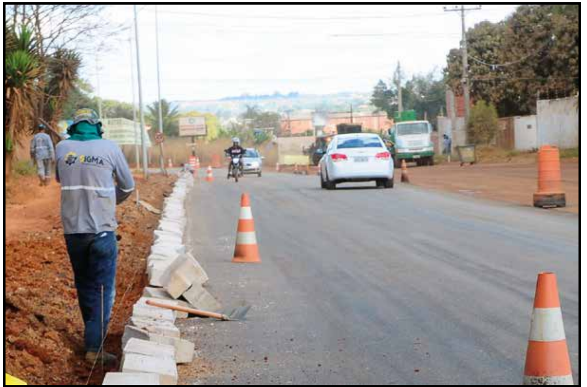
Obras vão drenar águas pluviais e recuperar o asfalto, para que os condomínios horizontais possam ser liberados para regularização
