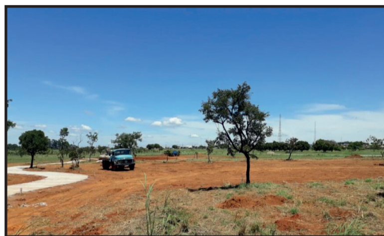
As obras já começaram no Parque de Santa Maria
