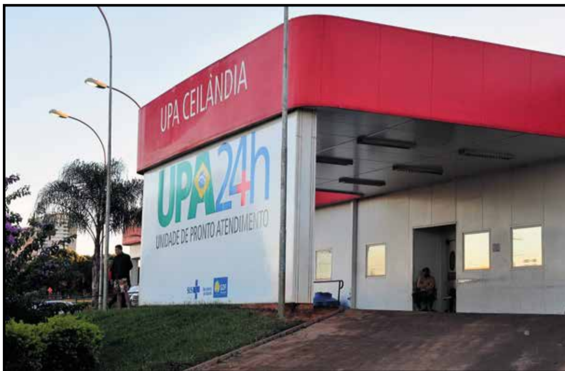
A UPA do Guarás será a do Porte 2, menor do que a de Ceilândia, mas deve comportar no mínimo 11 leitos de observação e capacidade para atender até 250 pessoas por dia
