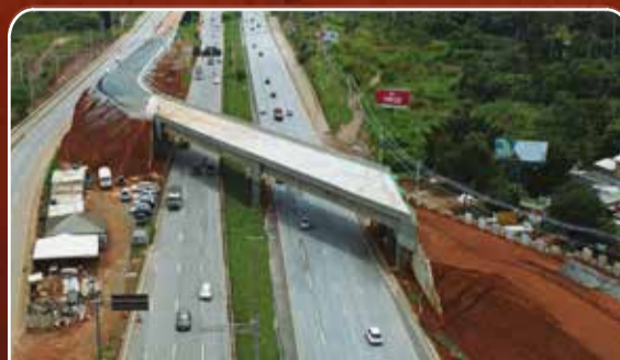
Último viaduto da Saída Norte quase pronto.
