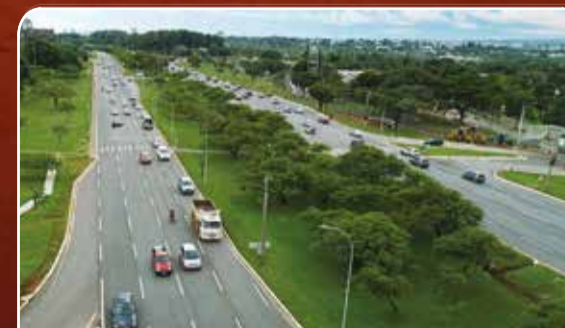
Asfalto de qualidade, novos meios-fios e mudas de ipê na EPIG.
