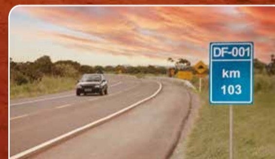
8,2 km de asfalto novo na DF-001 , em Brazlândia, que ainda será duplicado.
