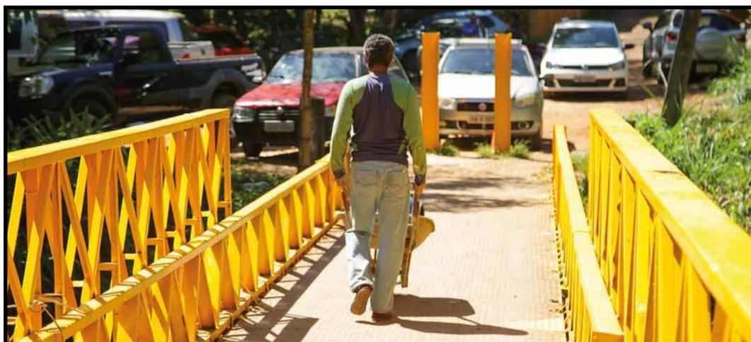
Ponte para pedestres sobre o córrego Vicente Pires liga o Bernardo Sayão à quadra 1 do Park Way. Estrutura metálica estava deteriorada e colocava em risco a segurança de pedestres
