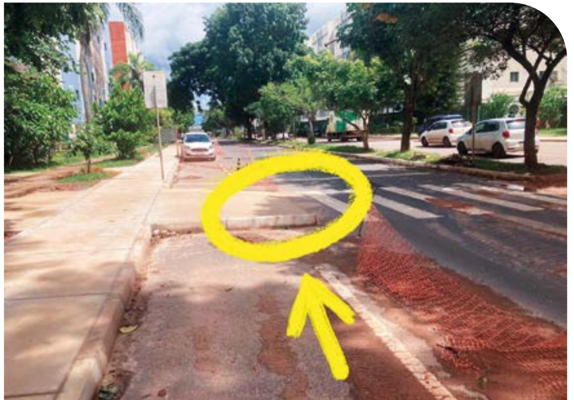
Motoristas reclamam de intervenções drásticas na via, com redução do espaço de circulação dos carros
