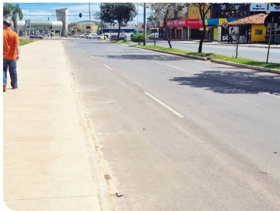
Construção de calçadas, rampas e faixa para bicicleta reduziu alguns trechos da pista pela meadde
