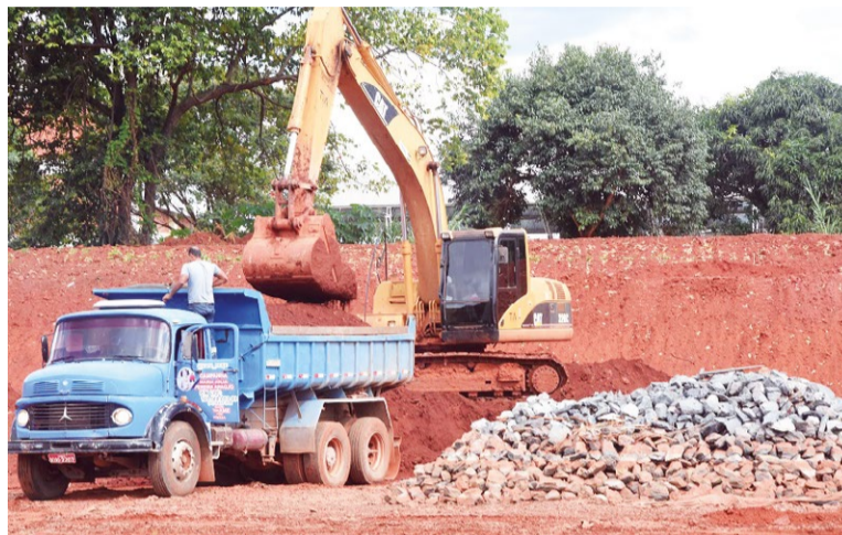
A construção das novas lagoas de detenção compõe as obras de regularização e parcelamento do Setor Habitacional Bernardo Sayão
