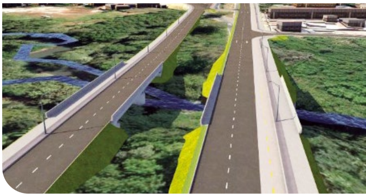
O projeto prevê a duplicação dos trechos ainda não duplicados, a construção de nova ponte sobre o córrego Vicente Pires, canteiro central e passarela de pedestres
