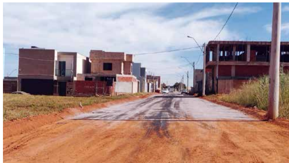
As obras de infraestrutura das quadras novas estão bem adiantadas
