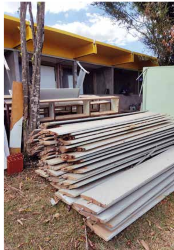
UBS 3, na QE 38, já começou a receber a reforma
