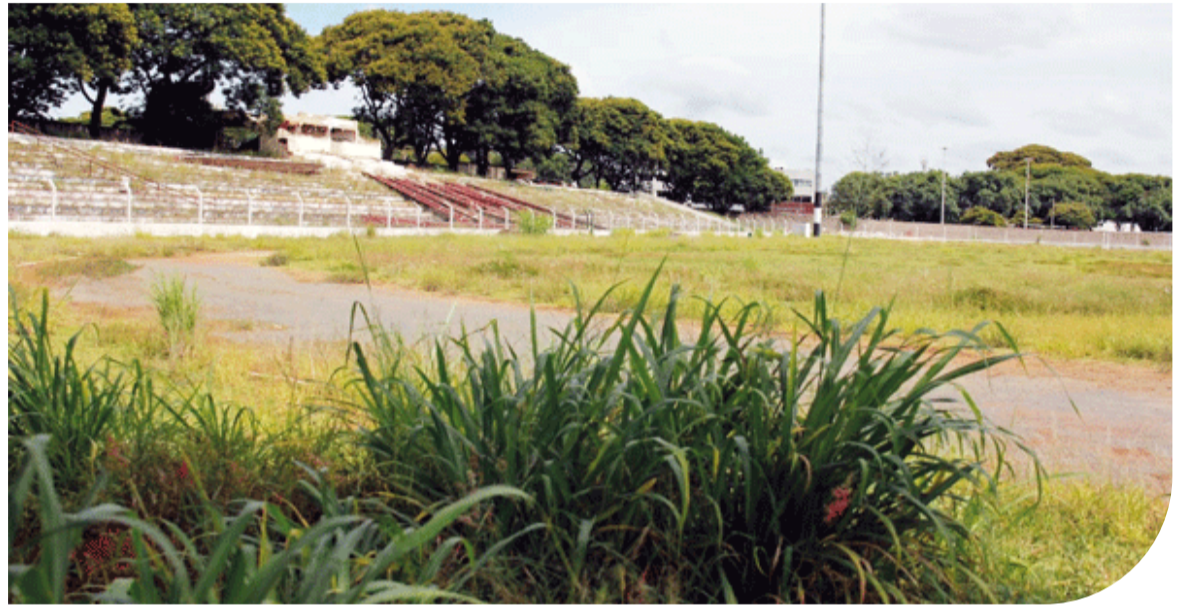
Parcialmente demolido há seis anos, o estádio do Cave aguarda a PPP para ser refeito
