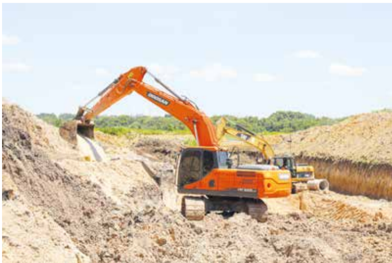
Com a chegada do período chuvoso, as atenções se voltam para a execução das redes de drenagem e para as escavações das lagoas de contenção de águas pluviais
