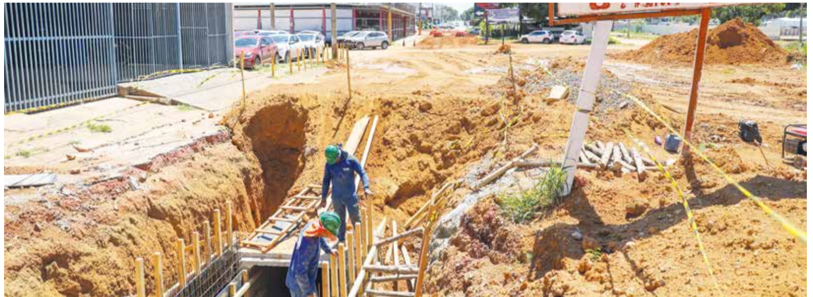
A rede de drenagem está sendo instalada para solucionar problemas antigos de alagamentos e enxurradas no SOF Sul
