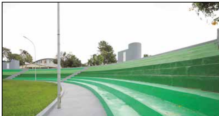
Arquibancadas e piso foram recuperados, impermeabilizados e pintados com tintas resistentes
