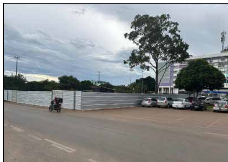
O lote não deveria ocupar a pista, que consta na planta do Centro Comunal;. Comerciantes alegam que o canteiro de obras poderia ter sido feito atrás do lote e não do lado, prejudicando todas as empresas instaladas
