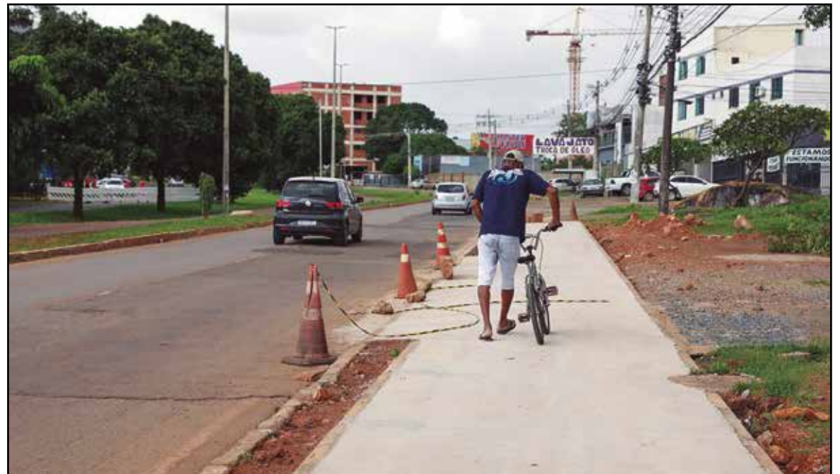
Novas calçadas e ciclovias vão levar mais segurança para pedestres e ciclistas que transitam pela via que conecta o Guarará ao Núcleo Bandeirante
