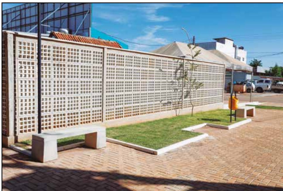
Construtora urbanizou um beco ao lado de um residencial, no Park Sul
