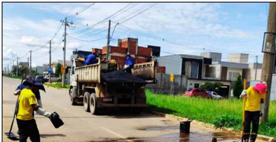
Execução dos serviços pela própria equipe da Administração Regional
