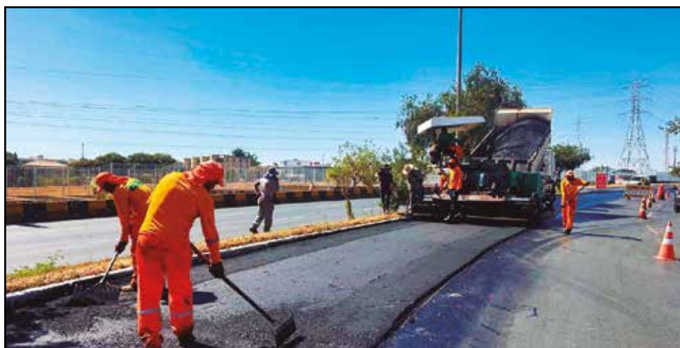
Trechos importantes como a Avenida Contorno e vias internas das quadras estão sendo recapeados para melhorar o tráfego e a segurança viária. Sistema de águas pluviais em implantação no Setor Bernardo Sayão e Park Sul ajuda a prevenir enchentes e aumenta a durabilidade do asfalto.
