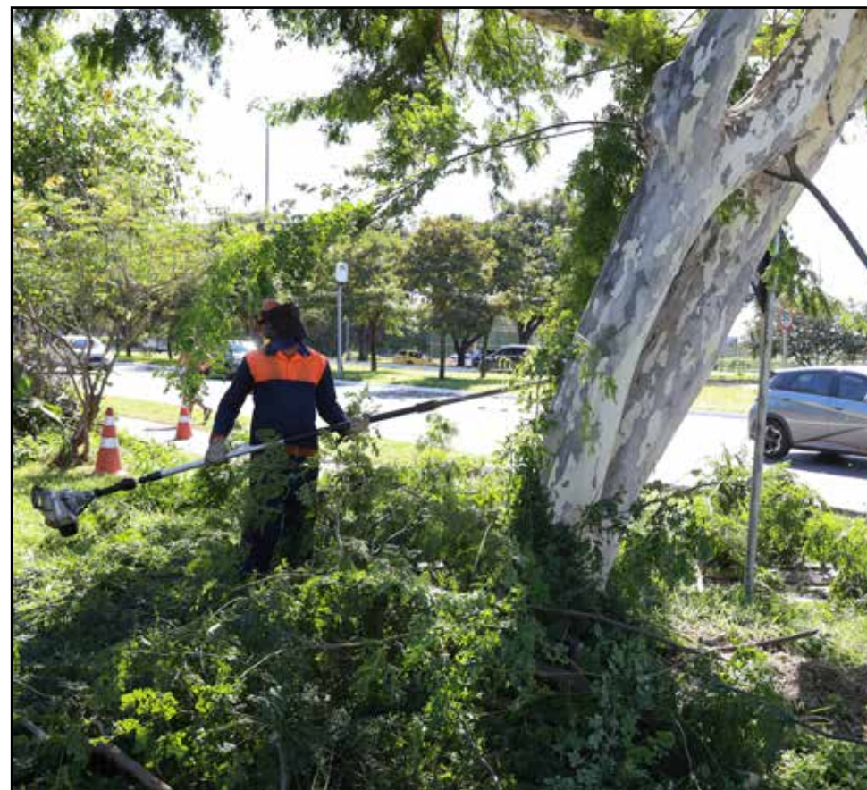
Cortes são feitos especificamente para evitar os riscos da conexão indevida de galhos com a rede elétrica
