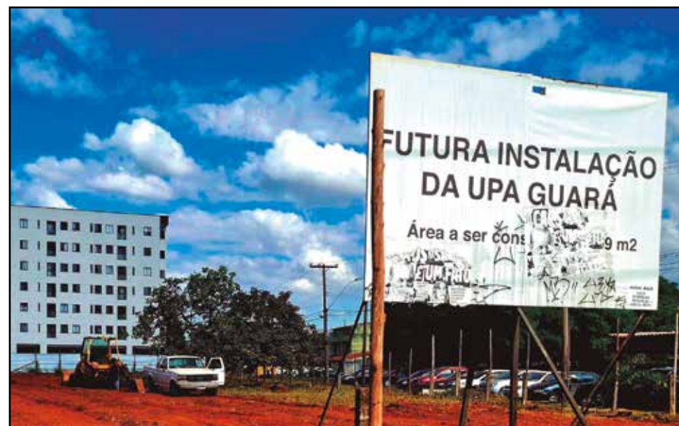
Empreiteira contratada já instalou o canteiro de obras e iniciou a terraplenagem do terreno, localizado na QI 23, ao lado da QE 24 do Guará II
