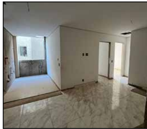
Interior de uma das unidades habitacionais do prédio irregular na chácara 6B. A construção já estava em fase final, com acabamentos e instalações praticamente concluídos.
