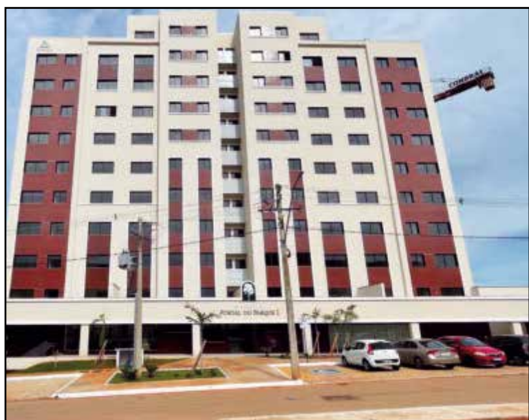
Portal do Parque I na QE 38, concluído...
