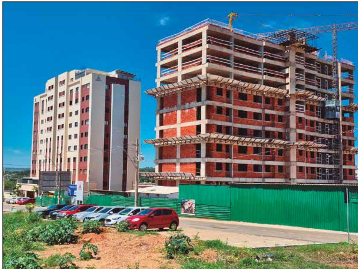
... e o Portal do Parque II na QE 48 em fase de ampliação
