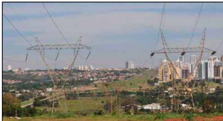
Avenida das Cidades vai ocupar a área onde está a linha de alta tensão de Furnas, que será enterrada
