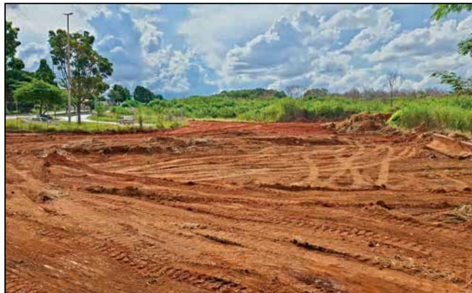
Área 27, em à QE 44 e o edifício Valentina, vai receber novo acesso e equipamentos de lazer e contemplam moradores das WES 42, 44, 46 e 48 a 58
