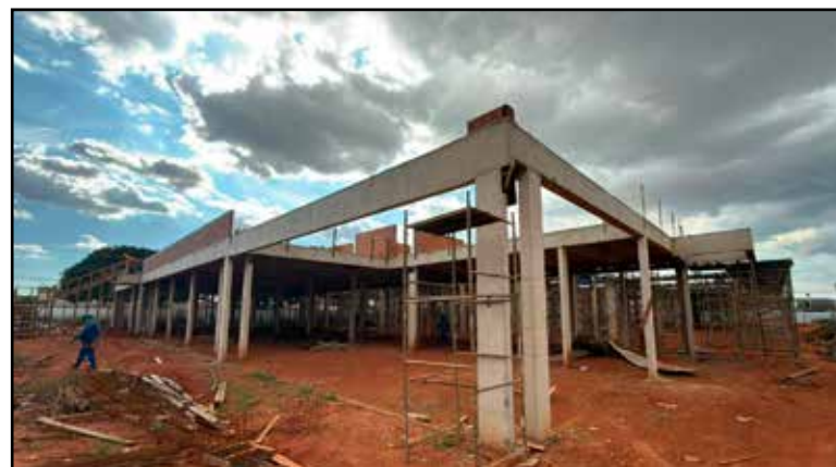
Prédio da UPA do Guarará sai do chão e vai para a reta final
