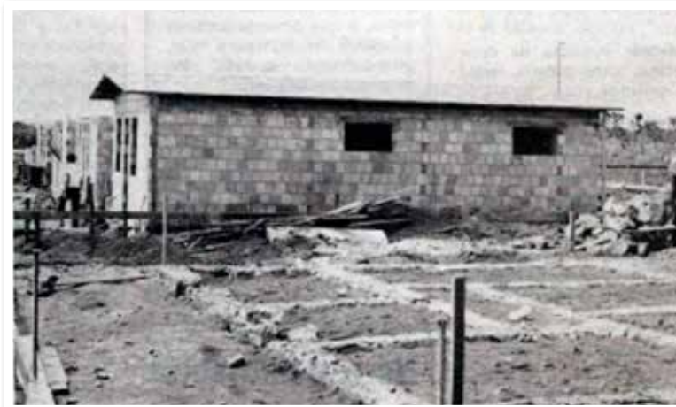
à construção da primeira casa...
