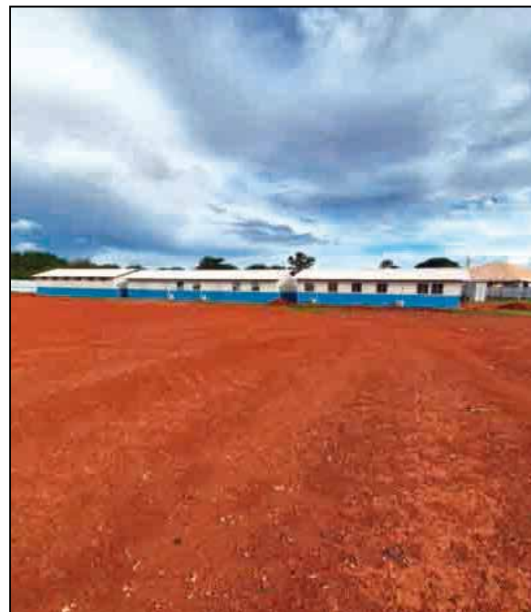
O canteiro de obras foi montado há um ano, ao lado das QEs 17 e 19 do Guará II, mas a burocracia provocou o atraso
