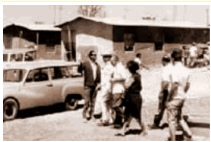
Trabalhadores do mutirão participam da construção das primeiras casas do Guará, ao lado do engenheiro Rogério de Freitas Cunha, responsável pela coordenação do projeto.
