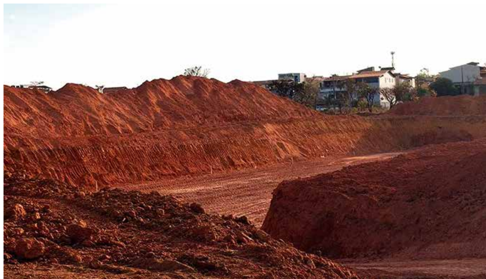
Obras de infraestrutura estão em andamento
